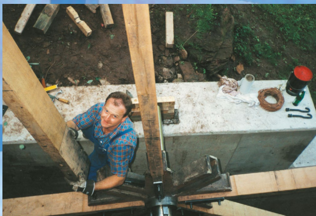
Montage der Radarme aus Eichenholz
