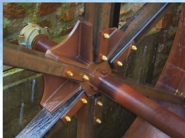
Wasserrad-Welle mit Rosette, Holzarme
